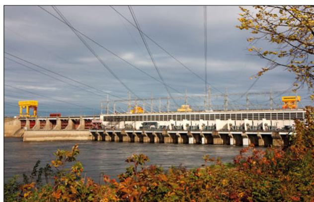
Гидроагрегат № 1 был введен в эксплуатацию в 1963 г., он отработал более 50 лет и достиг высокой степени износа. В ходе работ, которые планируется завершить в 2021 году, будут заменены гидротурбина, генератор, вспомогательное оборудование, модернизирована система автоматического управ-
